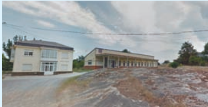
As obras de construción do anfiteatro
