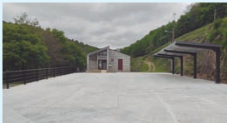
O novo aspecto da contorna do centro de saúde
