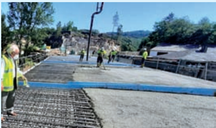
Labores de formigonado en Valdriz
