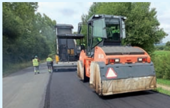
Unha imaxe do comezo das obras
