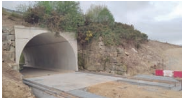
A nova autovía en obras
