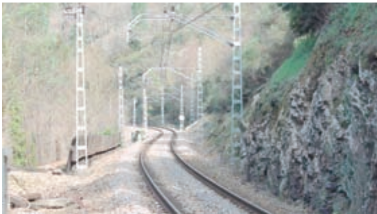
Un tramo da liña ferroviaria entre Monforte e Sarria
