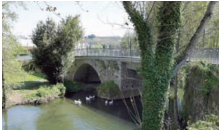
Ponte Ribeira de Sarria
