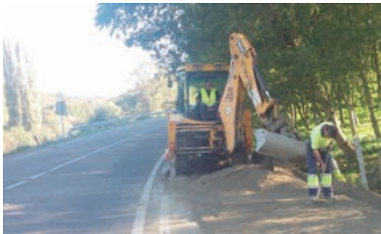
Unha imaxe das obras na vía
