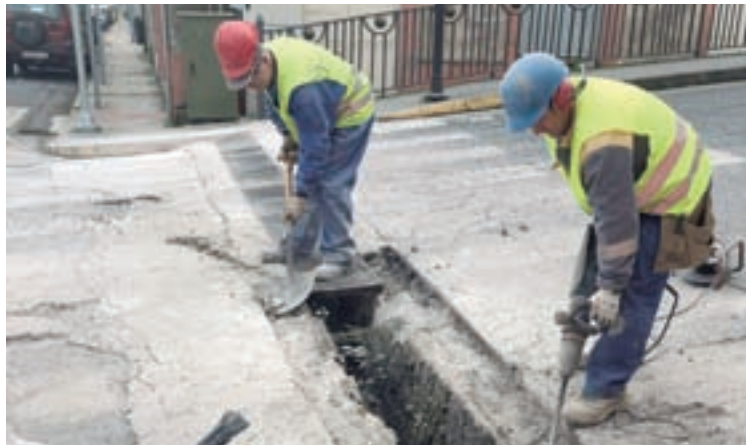
Obras que realiza a Deputación en Sarria
