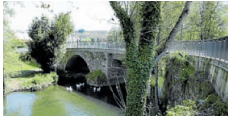
Ponte Ribeira de Sarria
