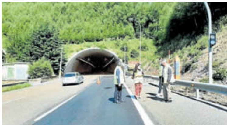
Aberto o desvío do tráfico polos derrubes do viaduto do Castro
